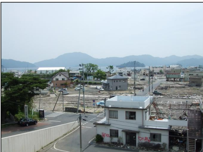
蔵や鉄筋の建物が残っていますが、海までの町はすべて津波とその後の火災で被害をうけました。
